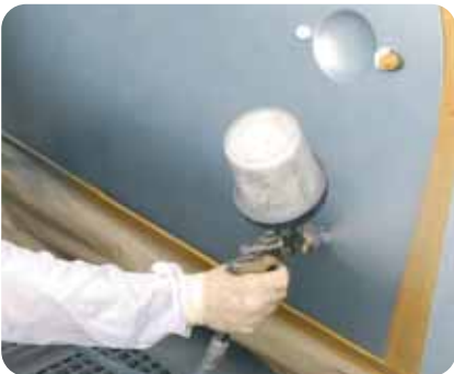
Baselakk sprøytes på nye deler / områder som er påført fyller. For å utjevne fargeforskjeller utflekkes ca. 10 cm av den tilstøtende delen.
